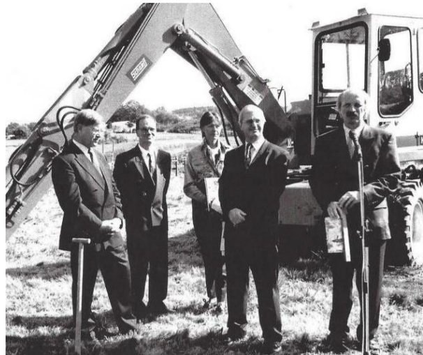
Beim „Spatenstich“ für den Bau des Hotels mit dabei: (v. links) v.l. Joachim Hörster, der damalige Landrat Peter Paul Weinert, Christiane Bensing, Helmut Schönberger und Erwin Bensing.
